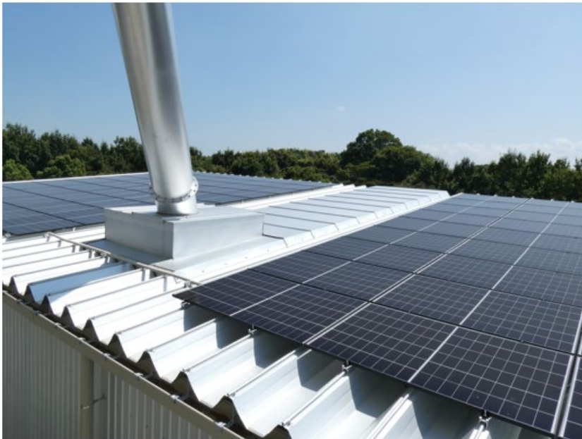
〔導入仕様〕太陽光発電パネル：合計 約 54kW / パワーコンディショナ：三相 40kW
